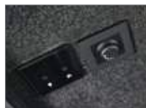
Schalter für Beleuchtung und Ventilator
